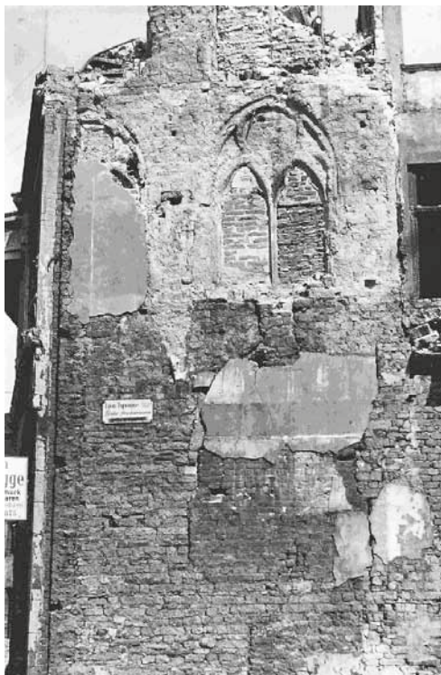
Abb. 36 und 37: Reste der Fassade eines frühgotischen Hauses, Knüppelmarkt 3, 1949 beim Abbruch des Hauses entdeckt, Mitte 13. Jahrhundert. Fotos: Stadtarchiv Duisburg.
