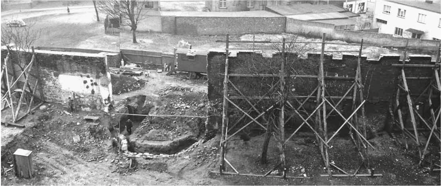
Abb. 33: Stadtmauer an der Obermauerstraße. Blick von der Feldseite nach Abbruch des Ziegelturmes (Abb. 31 und 32) und der an die Mauer angebauten Gebäude vor der „Runderneuerung“ (Abb. 34 und 35). Foto: H. Falkowski 1965.
