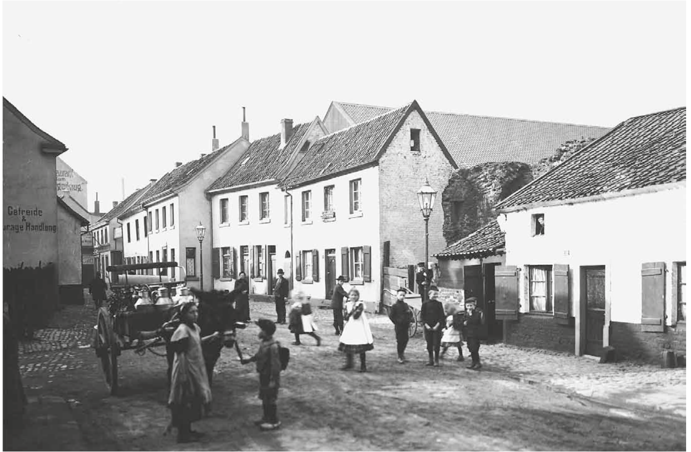
▲ Abb. 22: Unterstraße nahe dem Schwanentor um 1900. Halbrundturm der Stadtmauer aus der ersten Hälfte des 13. Jahrhunderts zwischen Häusern, die die Stadtmauer als Rückwand benutzen, wie es überall in der Altstadt bis in die Nachkriegszeit der Fall war. Foto: Stadtarchiv Duisburg.
