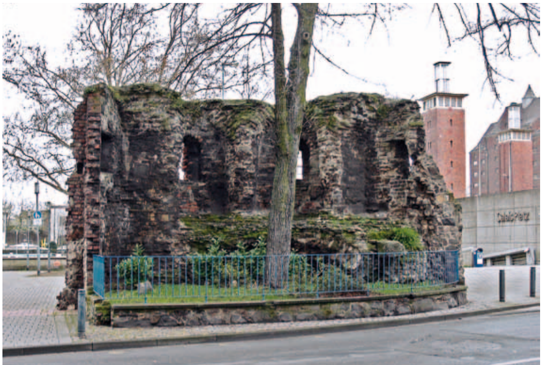
Abb. 27 und 28: Der Turm der Stadtmauer an der Unterstraße, Situation 2008. Die Verkehrsinsel wurde zwischenzeitlich zurückgebaut, so dass der Turm jetzt wieder an der Unterstraße liegt. Oben Feldseite, unten Stadtseite. Fotos: G. Krause.
