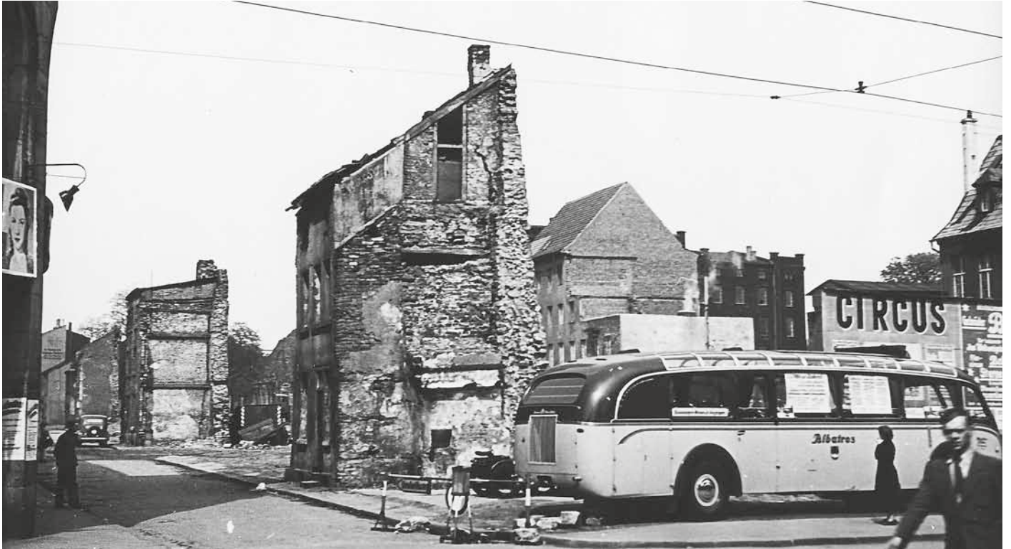
Abb. 29: In voller Höhe erhaltene Stadtmauerteile des frühen 12. Jahrhunderts als Rückwand der Häuser an der Obermauerstraße östlich des Kuhtors 1950. Foto: Stadtarchiv Duisburg.
