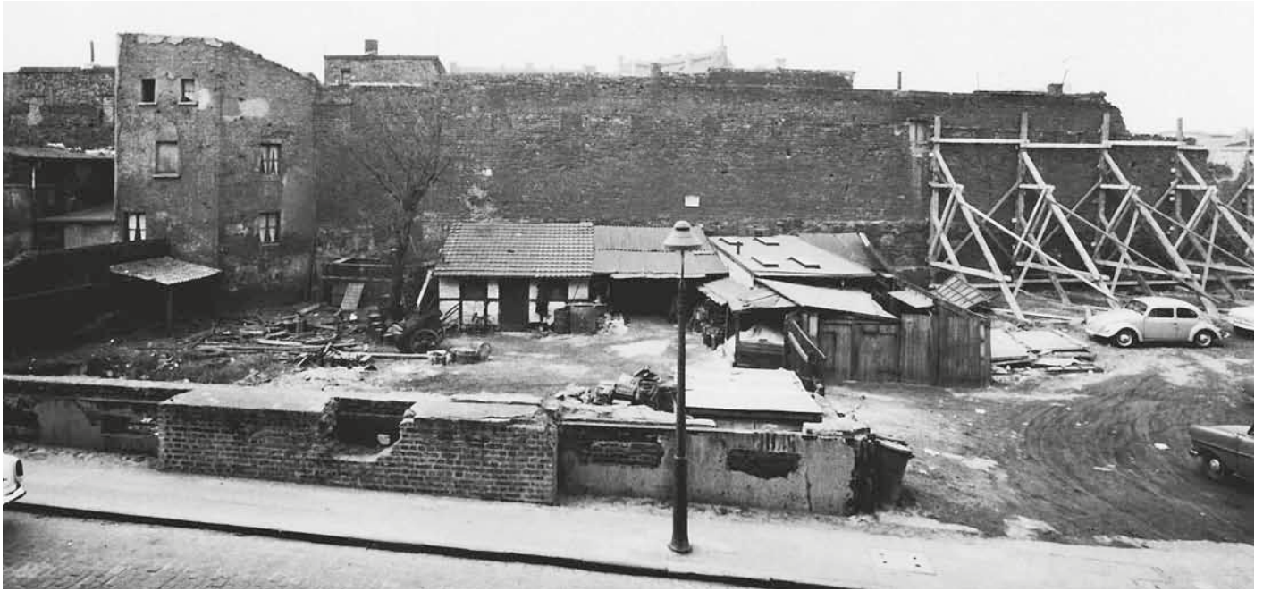
Abb. 31: Stadtmauer aus dem frühen 12. Jahrhundert an der Obermauerstraße südlich des Stapeltores, Feldseite, Blick vom Kuhlenwall. Der größte Teil des abgestützten Mauerabschnitts wurde im Dezember 1964 wegen angeblicher Baufälligkeit vom städtischen Hochbauamt ohne die erforderliche Genehmigung durch die Denkmalbehörden abgebrochen. 1965 folgte der gut erhaltene Stadtmauerturm aus Ziegeln (links im Bild und Abb. 32), der im 13. Jahrhundert in die ältere Mauer eingefügt worden war (Abb. 33). Er wurde durch einen frei erfundenen Rundturm aus Naturstein ersetzt (Abb. 34). Die restliche Mauer wurde 1968 „runderneuert“ (Abb. 34 und 35). Foto: Stadtarchiv Duisburg 1962.
