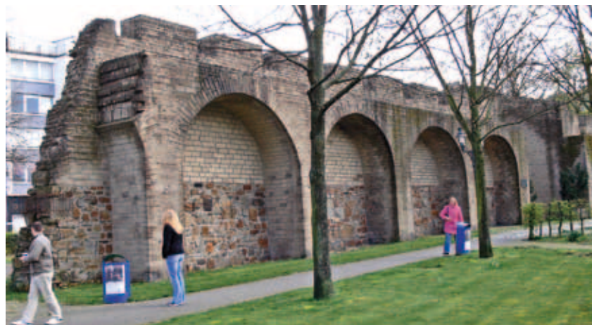
Abb. 34 und 35: 1966–68 für das Mauerstück in Abb. 31–33 teilweise neu gebauter Mauerabschnitt. Davor war das Angebot einer Duisburger Baufirma, auf eigene Kosten die Originalmauer (Abb. 31) zu restaurieren, abgelehnt worden. Oben Blick von der Feldseite auf die Mauer. Nur diese ist noch teilweise im Original erhalten, der Turm frei erfunden. Im 13. Jahrhundert war der hölzerne Wehrgang in Ziegelstein ersetzt worden. Der unten sichtbare Wehrgang aus Tuff und Bruchstein, fälschlich in die Mauer einbindend, stammt aus den 1960er Jahren. Höhe der Mauer 7,70 m, Dicke rund 1 m. Abb. 34: Foto: Sky-robot 2009, Abb. 35: Foto: G. Krause 2008.
