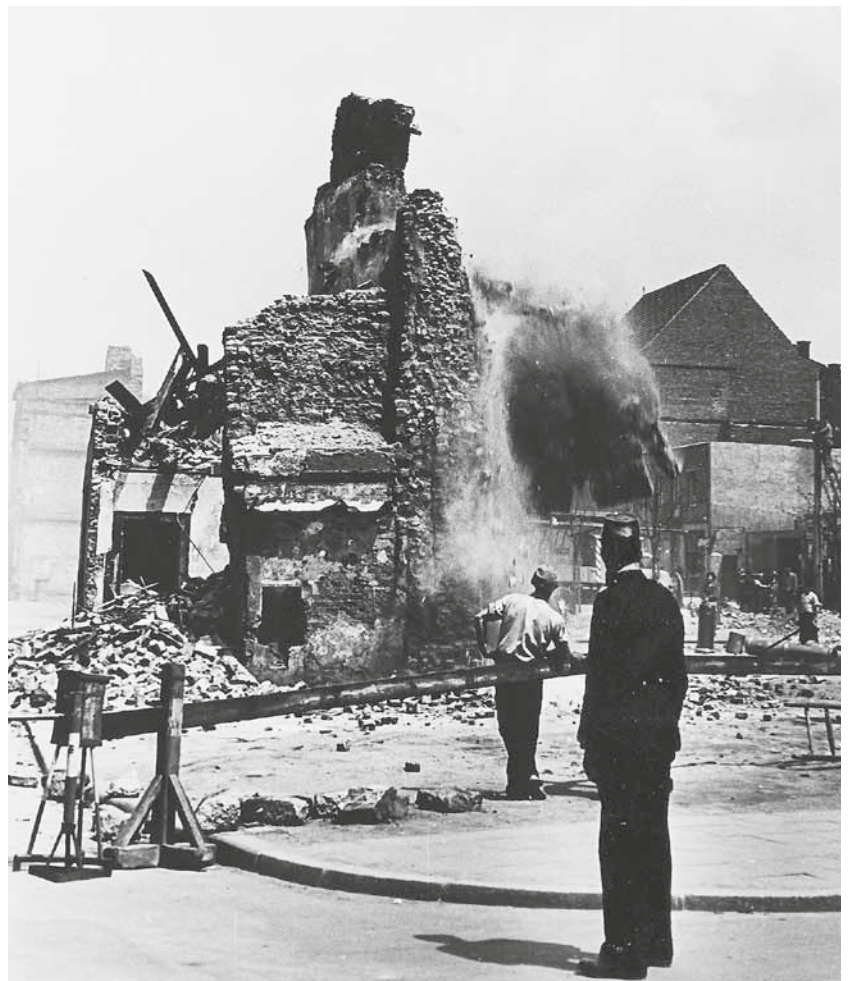
Abb. 29: In voller Höhe erhaltene Stadtmauerteile des frühen 12. Jahrhunderts als Rückwand der Häuser an der Obermauerstraße östlich des Kuhtors 1950. Foto: Stadtarchiv Duisburg.
